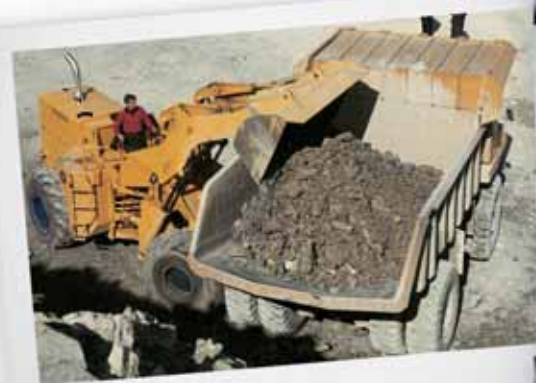
1967 wurde das Gestein zuerst von einem Radlader aufgenommen und auf LKWs verladen.
