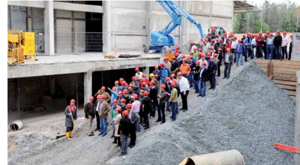
Am 9. Oktober legten alle LEUBE Mitarbeiter bei einem festlichen Akt den Grundstein für die Erneuerung der Klinkerproduktion.
