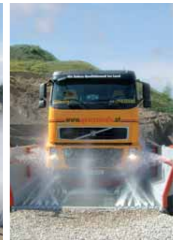
Die Anrainer sind mit der neuen Reifenwaschanlage und der damit verbundenen Reduktion der Staub- und Schmutzbelastung im Siedlungsbereich sehr zufrieden.
