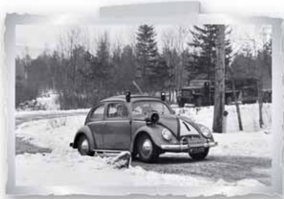
1959 Neubau Drehrohren I: Hier wird gerade der Schwertransporter mit einem Ofenring von der Polizei zur Baustelle eskortiert.
