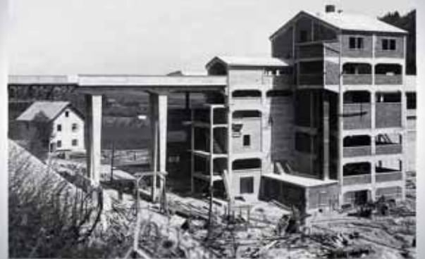
1930: Neubau des Hochleistungsschachtofen I und der Klinkerhalle. In den Hochleistungsschachtofen I bis IV wurde damals LEUBE Zementklinker hergestellt.
